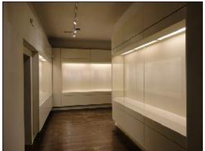
Αίθουσα 5 της εν εξελίξει κατασκευής της Νέας Ιαπωνικής Πτέρυγας στον Β' όροφο
